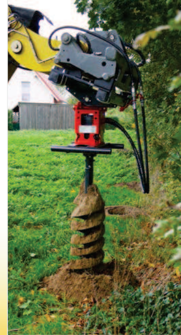
Erdbohrer im Einsatz am Radlader
